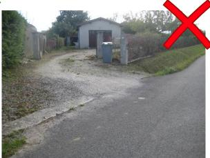
En agglomération et hors de celle-ci, les têtes d'aqueduc et ponceaux seront réalisés par éléments biseautés sans obstacle saillant (tête de buses normalisées) afin de limiter la gravité des accidents lors des sorties de route, faciliter l'entretien et prévenir l'obstruction des buses.
